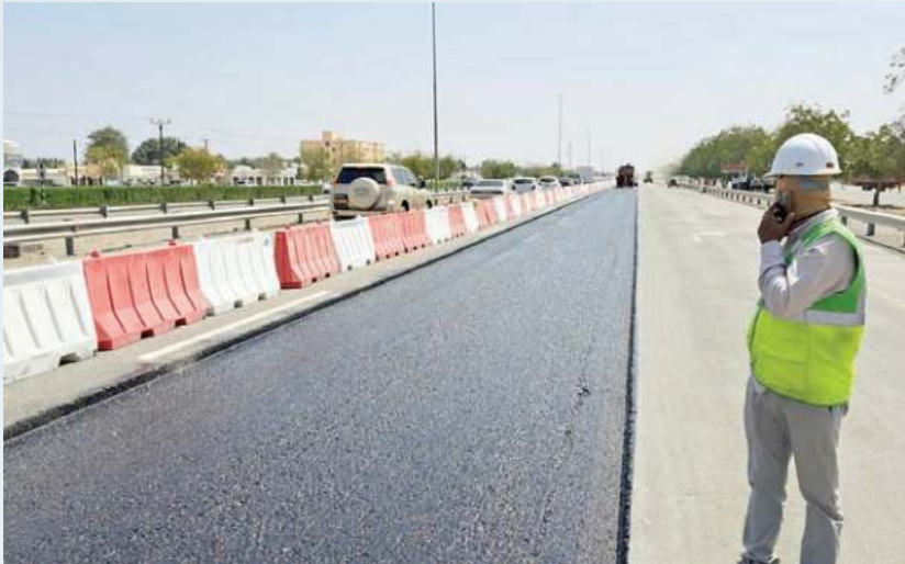
تشتمل أعمال المشروع على استبدال طبقات الأسفلت بطول إجمالي يبلغ ٧٣ كيلومتراً على امتداد طريق الباطنة العام
