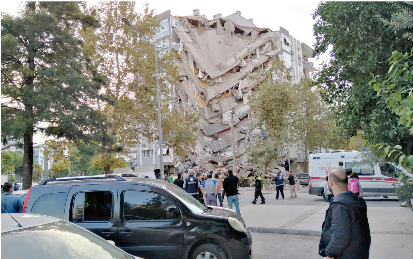
■ انهيار مبنى سكني إثر الزلزال في مدينة أزمير التركية الساحلية.
