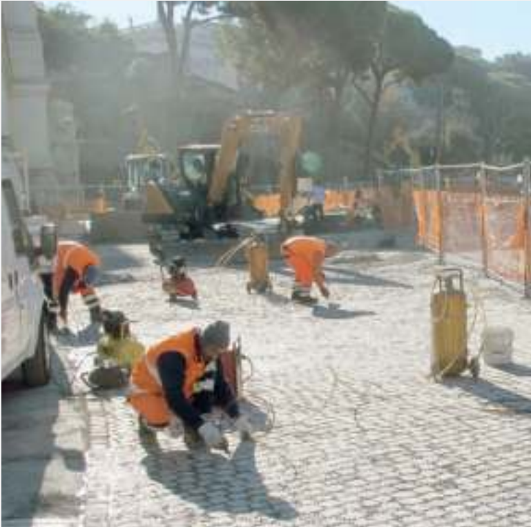
عمال البناء يضعون حجارة الرصف في ساحة فينيسيا
