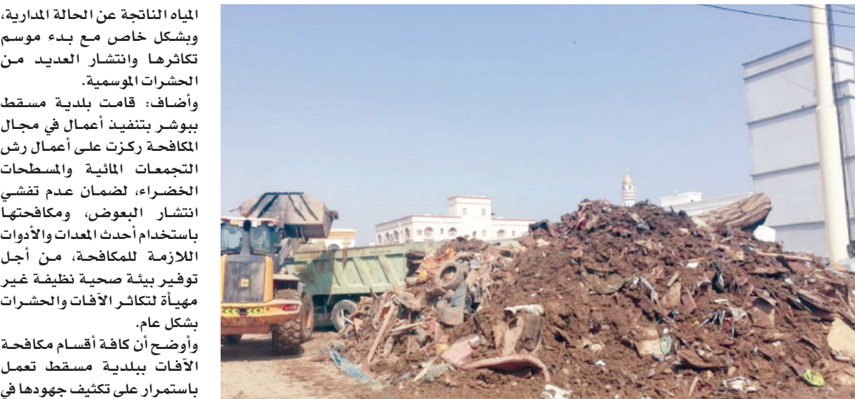
تجميع ونقل المخلفات وتنظيف المواقع
