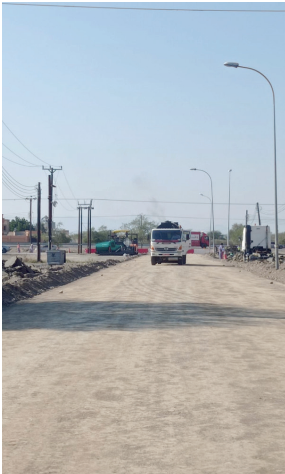
من أعمال رصف طريق قرية مقاعسة
