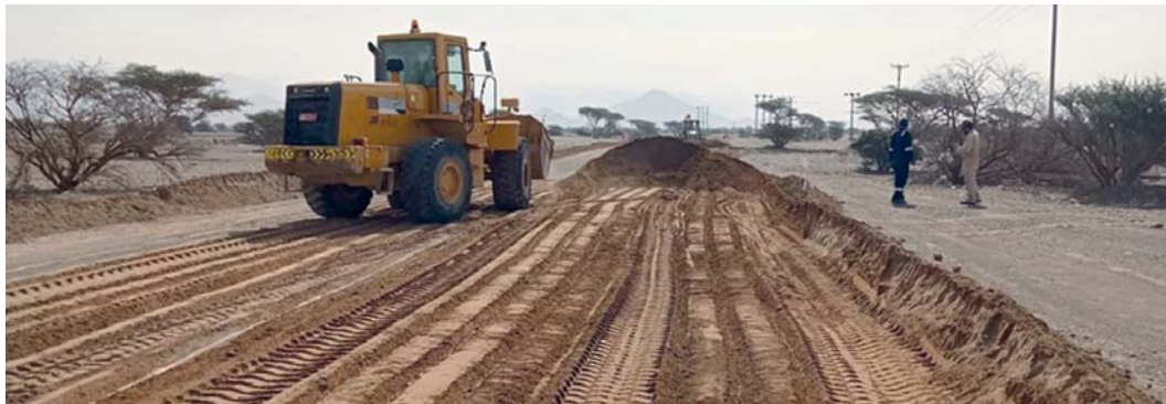
■ أثناء رصف أحد الطرق بالولاية
