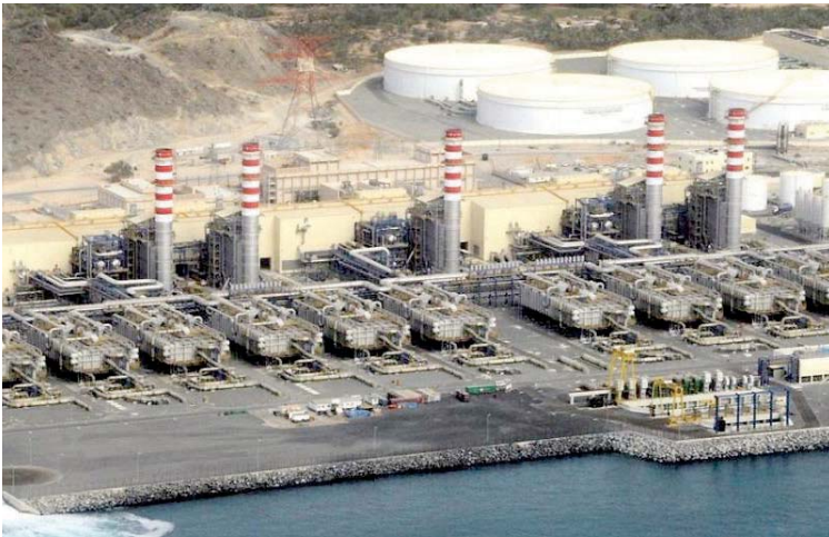
محطة صحرار لتحلية المياه
