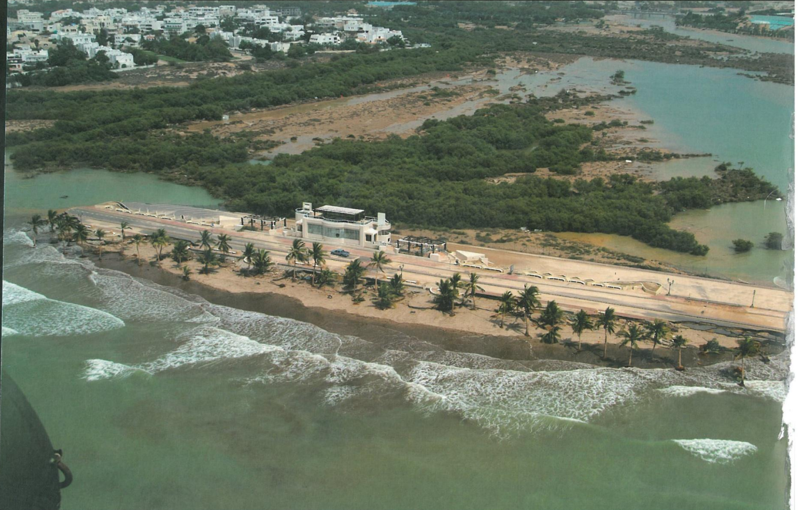
لقطة جوية توضح الأضرار التي لحقت بطريق القرم البحري .
