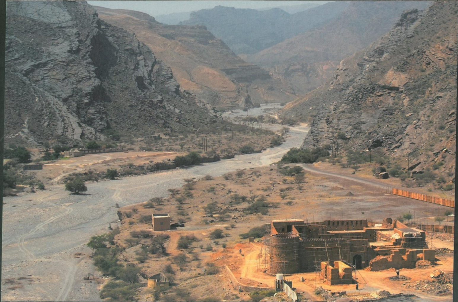
معلم أثري تحت الترميم في وادي بني خروص بولاية العواري.
